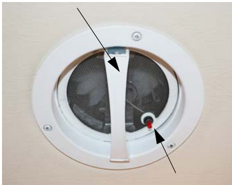
Fan Power Switch
