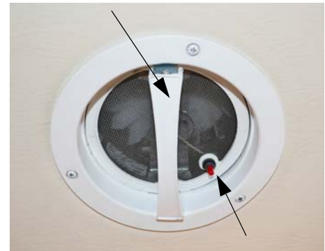
Fan Power Switch
